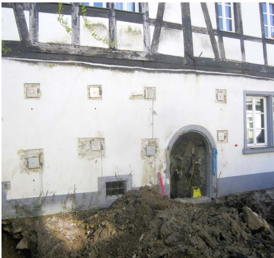
(4) Grundsicherung der Giebelwand
