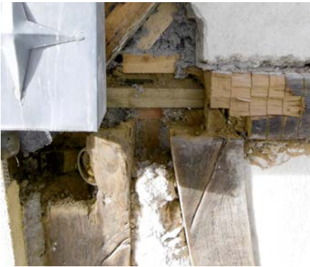
(6) Freigelegte und in Reparatur befindliche Fachwerkkonstruktion hinter dem Einlaufkasten
