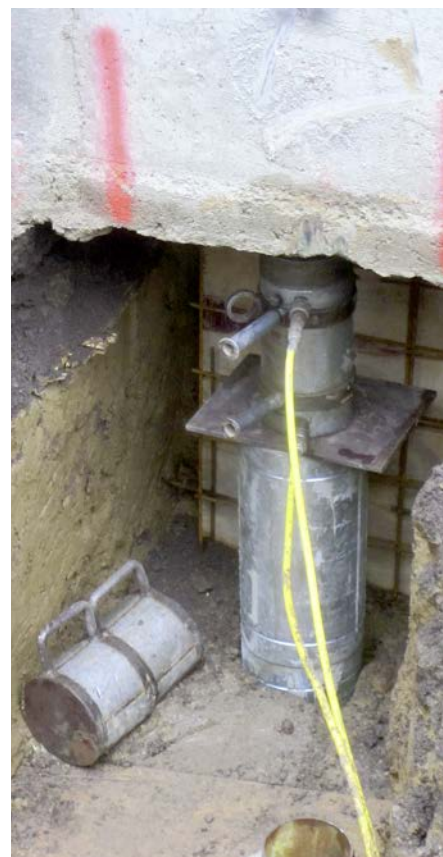
(5) Hydraulische Presse mit Zylinderkern zum Eintreiben in den Untergrund
