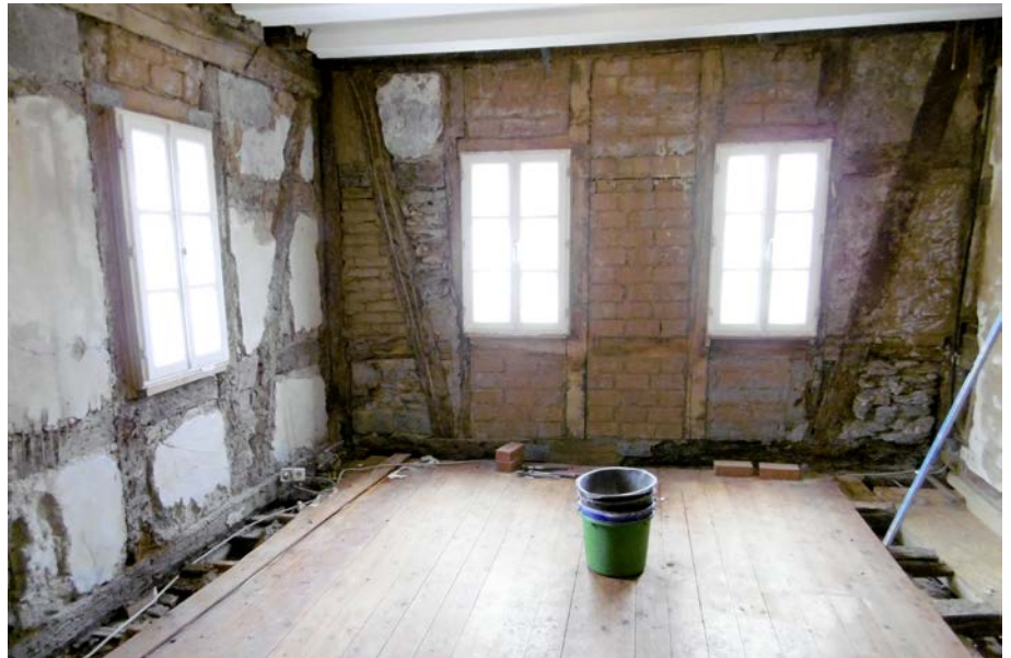
(13) Frei gelegte Innenwände, Fachwerk und Balkenköpfe, sodass die Holzkonstruktionen auf Beeinträchtigungen untersucht werden können.
