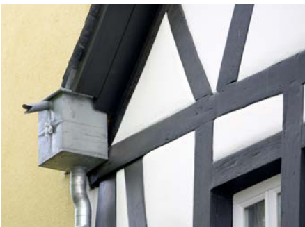
(7) Nach der Sanierung: Instand gesetzter Einlaufkasten und Fachwerk mit fertigem, erweitertem Dachüberstand
