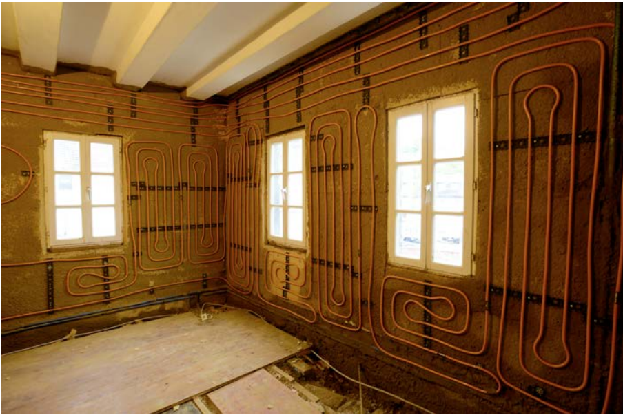
(14) Mit Lehmputz ausgeglichene Wandflächen mit aufgebracht Holzfaserdämmung und montierten Wandheizungsrohren
