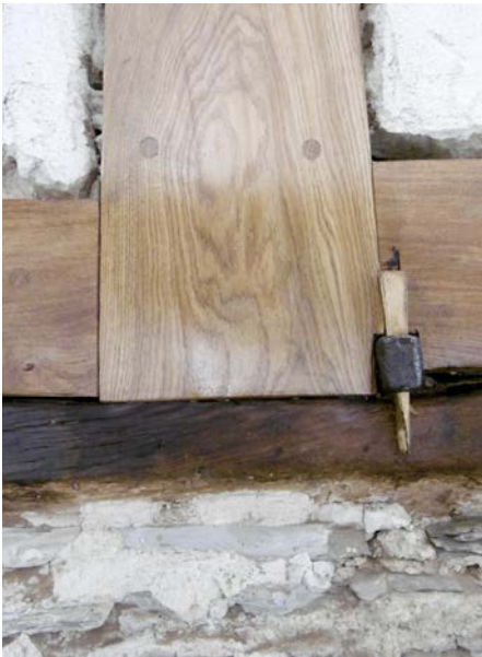
(12) Instand gesetzter Bereich am historischen Zuganker mit übergangsweiser Absicherung des Zugstabs mit einem Holzkeil.
