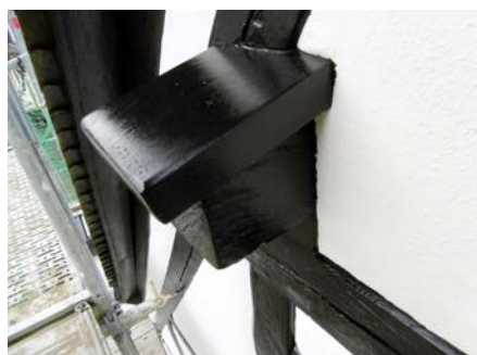
(9) Nach der Sanierung: Balkenkopf mit Opferholz in fertigem Zustand
