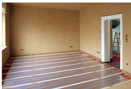
Abb. 2 – 4: Verlegung des Heizsystems im Trockenbauverfahren mit geringer Aufbauhöhe
