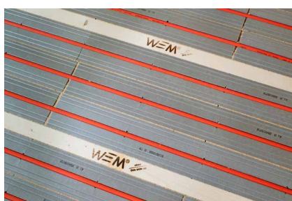
Abb. 6 – 8: Verlegung der Wärmeleitbleche und der Heizungsleitungen aus Mehrschicht-Verbundrohr auf Holzfaserplatten und Verfüllung mit einer Schüttung
