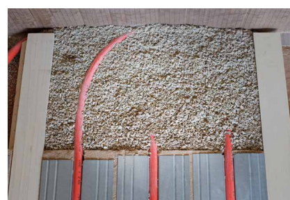
Abb. 6 – 8: Verlegung der Wärmeleitbleche und der Heizungsleitungen aus Mehrschicht-Verbundrohr auf Holzfaserplatten und Verfüllung mit einer Schüttung
