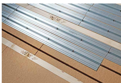
Abb. 6 – 8: Verlegung der Wärmeleitbleche und der Heizungsleitungen aus Mehrschicht-Verbundrohr auf Holzfaserplatten und Verfüllung mit einer Schüttung
